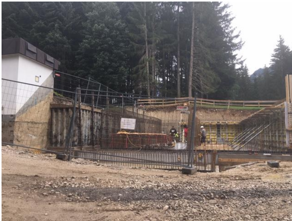
Zubau eines neuen Hochbehälters beim bestehenden HB Bad Mitterndorf
